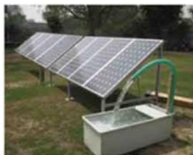
Pompa Air Tenaga Surya
